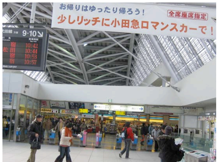
SOLAR ARRAY ROOF (ODAWARA, JAPAN)
